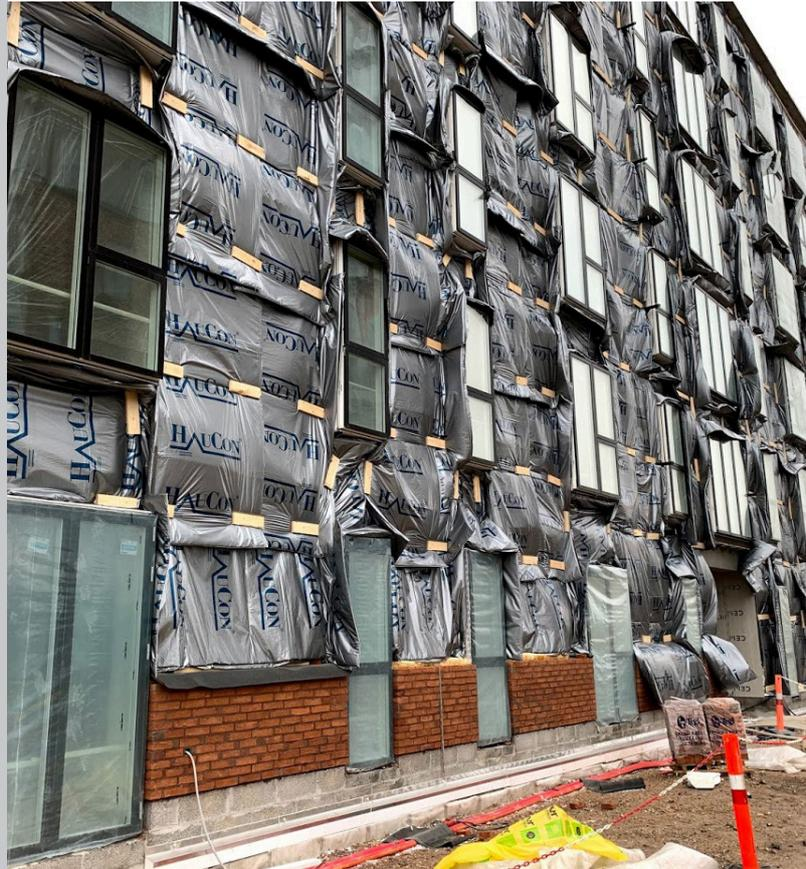
*Die Wintermatten von Combitherm mit HauCon-eigenem Logo wurden entwickelt, um das Gebäude vor Frost, Regen, Hitze und Sonneneinstrahlung zu schützen. Die Wintermatten werden zur Abdecken neu gegossener Fundamente und anderer Formen von Mauer-, Guss- und Erdarbeiten verwendet.*
